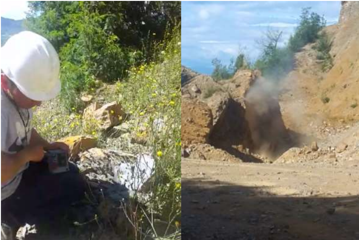
Figura 35: Voladura Carga Interna
