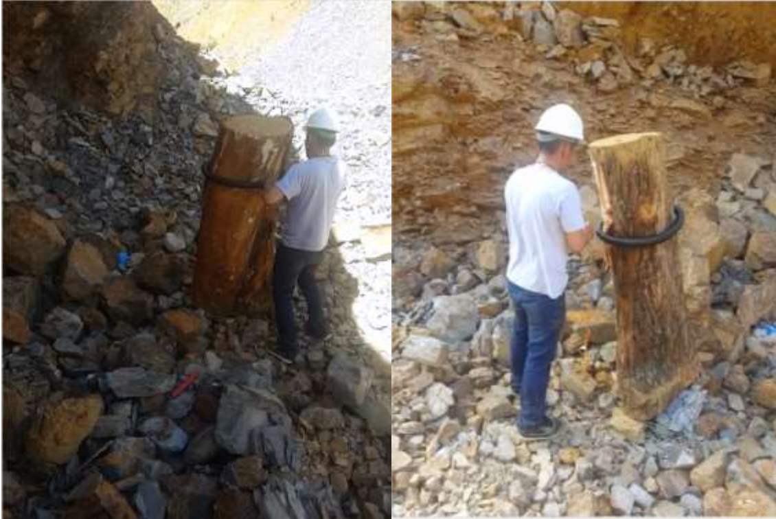
Figura 43: Montaje Colocación Dispositivo para Carga Externa
