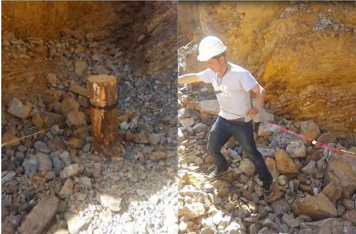
Figura 44: Conexión con Explosor para Prueba Externa
