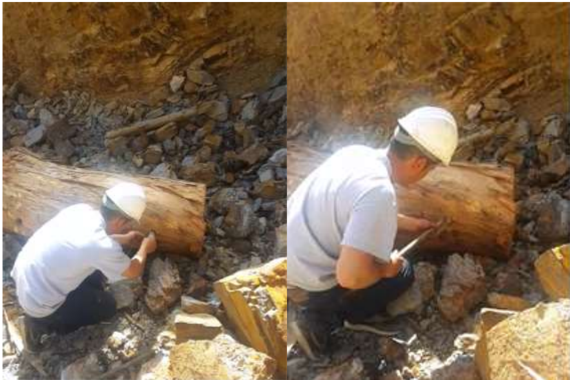
Figura 33: Retacado del Barreno para Carga Interna Fuente: Elaboración propia
