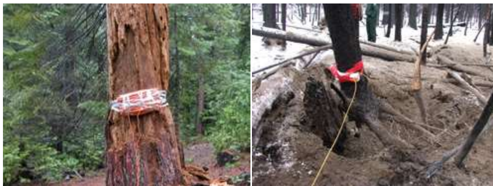
Figura 14: Colocación de carga explosiva externa
