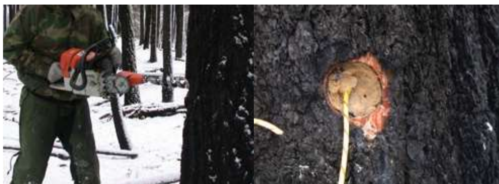
Figura 13: Colocación de carga explosiva interna
