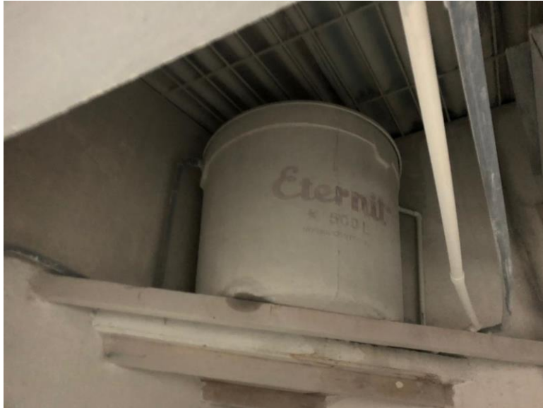
Ilustración 5 Tanque de almacenamiento, Foto Tomado por Sebastián Espinosa
