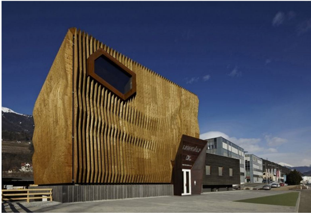
Ilustración 1 edificio en CLT Italia (Stora Enso 2017)
