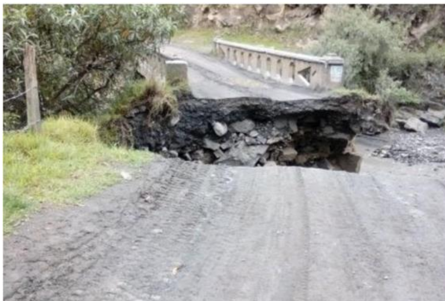
Ilustración 5: Problemas de estabilidad por épocas de lluvia
