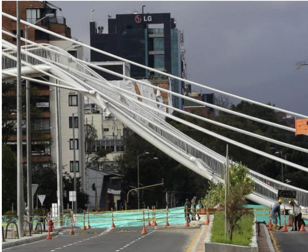
Puente calle 101 con 11
