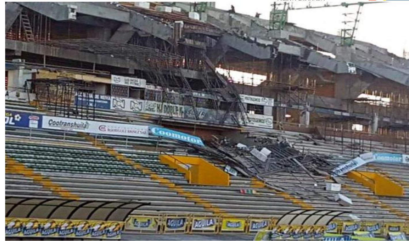
La estructura de la tribuna occidental del estadio de fútbol Guillermo Plazas Alcid, de Neiva
