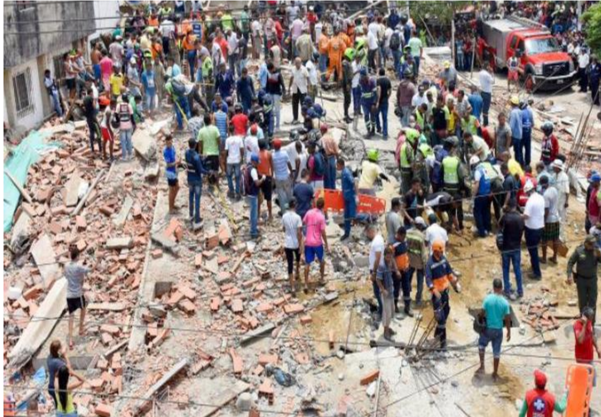
Caída de la edificación Portal Blas de Blezo II
