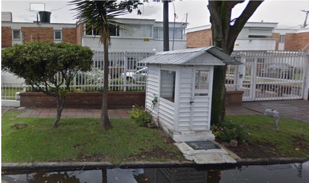
Figura 9. Caseta de vigilancia, entre la carrera 70 y las calles 129 – 120, barrio Niza Sur, localidad de Suba
