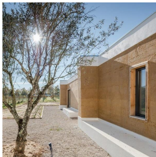
Ilustración 13: Construcción moderna con tierra apisonada o tapial.
