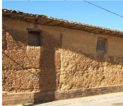
Ilustración 10: Construcción antigua con tierra apisonada o tapial. Tomado de: https://construyediferente.com/tapial-tecnica-antigua-nueva/
