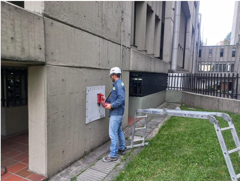
Ilustración 41 Proceso de detección de acero Fuente: Elaboración propia.
