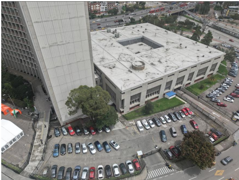
Ilustración 83 Vista suroriental de vuelo. Fuente: Elaboración propia.
