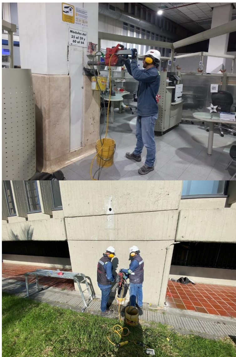
Ilustración 40 Proceso extracción de núcleos Fuente: Elaboración propia.
