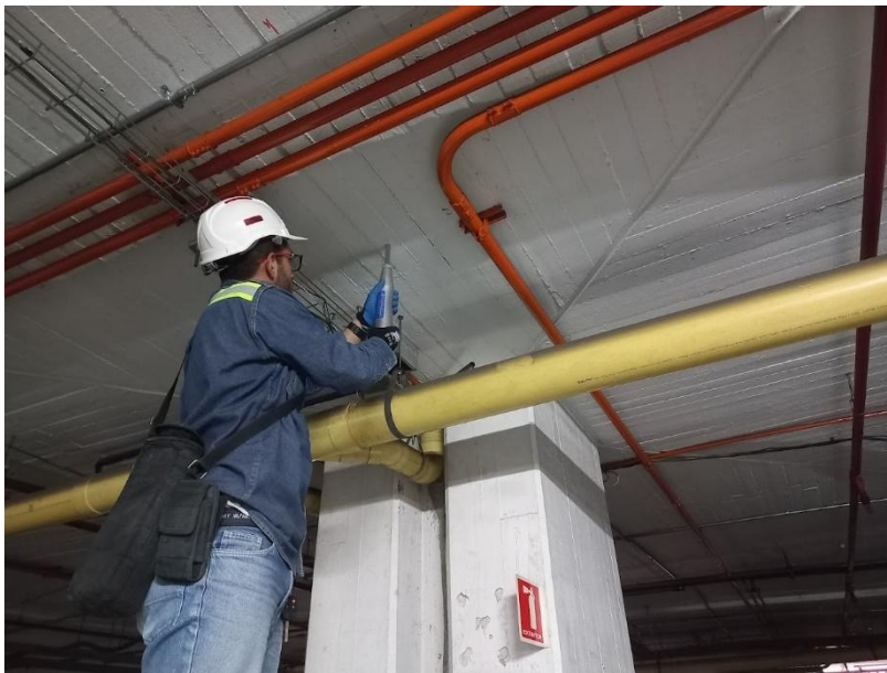
Ilustración 43 Proceso de evaluación del concreto por el esclerómetro Fuente: Elaboración propia.
