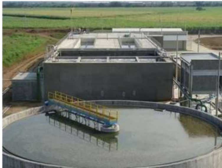
Imagen 2. Estaciones de efluentes. Tomada de Condorchem Envitech
