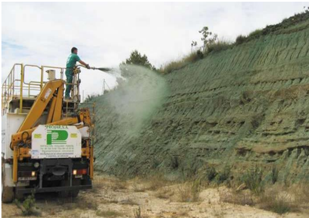
Figura 8. Trabajos de hidrosiembra.
