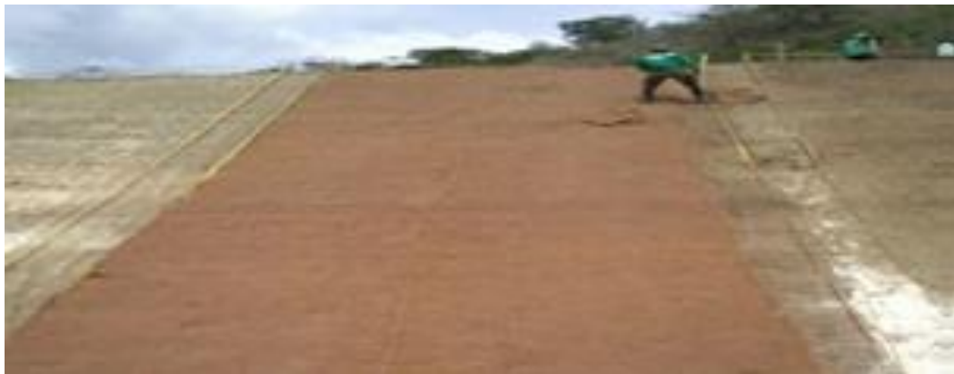
Figura 6. Trabajos de cubrimiento con fibra de coco.
