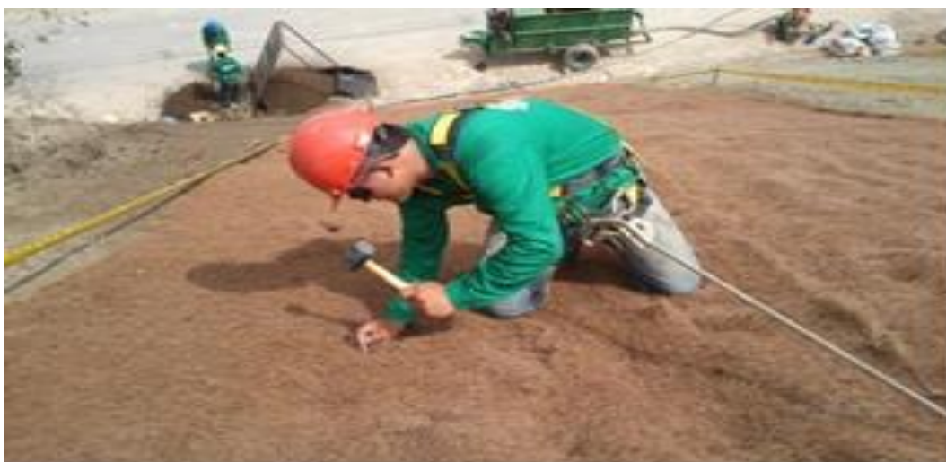
Figura 7.Trabajos de cubrimiento con fibra de coco.
