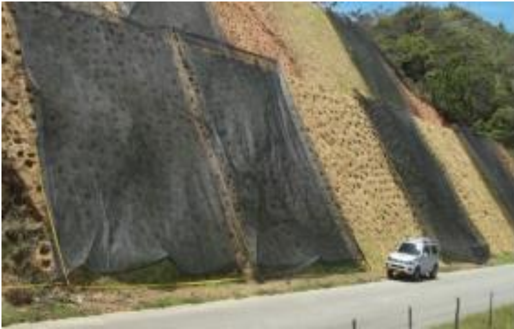
Figura 14. Terraceo o taludes en escalera. Fuente: Castillo (2014).
