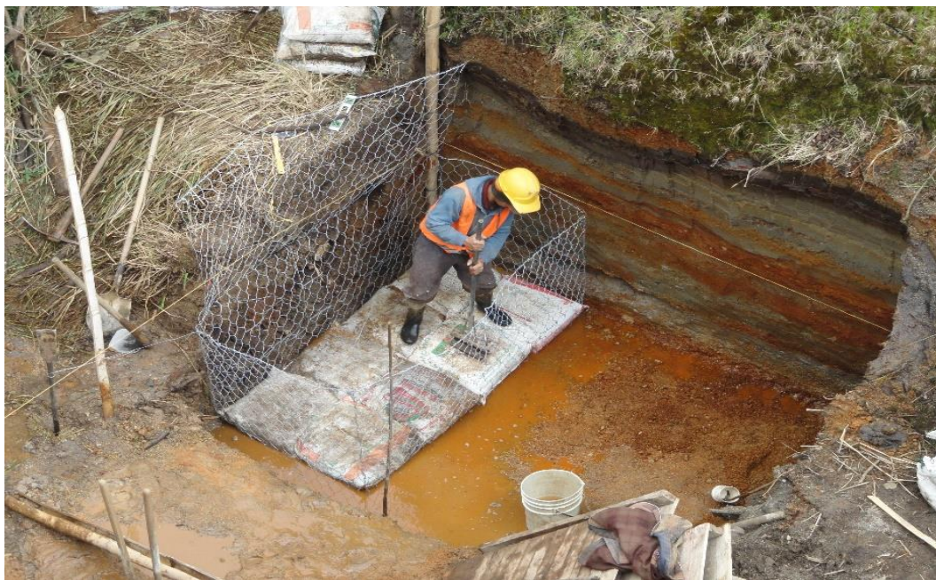
Figura 2. Gaviones en saco suelo semillado
