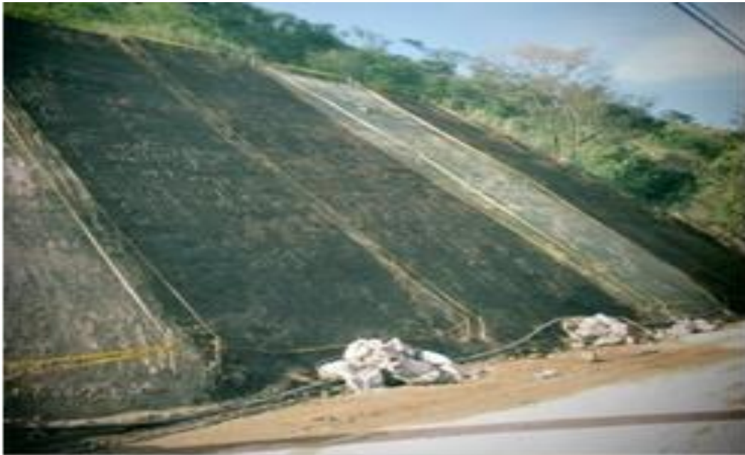
Figura 9. Trabajos de hidrosiembra Antioquia-Liborina.
