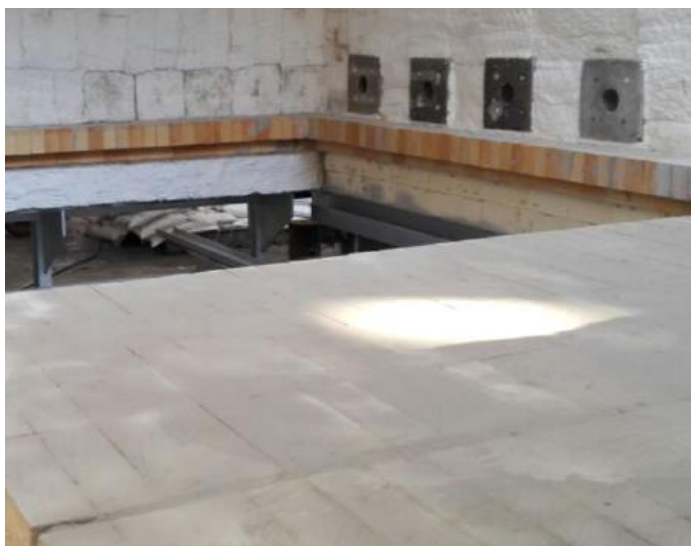
Figura 15. Instalación ladrillo refractario
