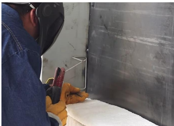
Figura 6. fijación Ancla Tipo U
