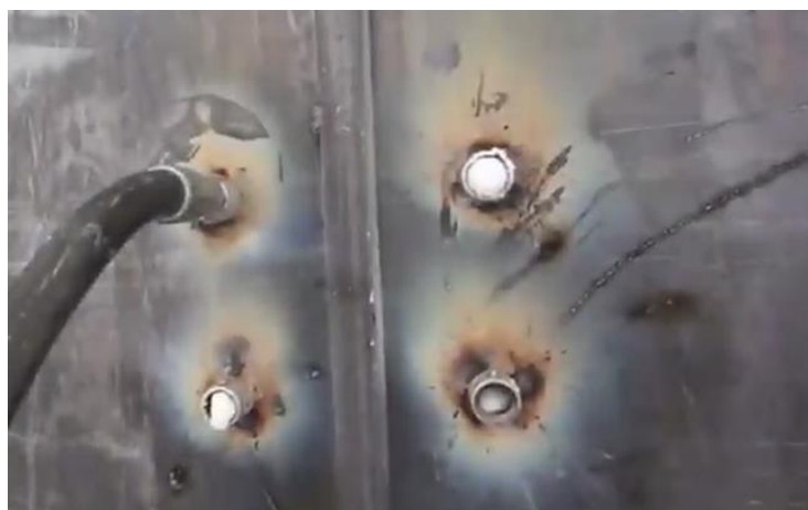
Figura 13. Inyección de fibra cerámica bombeable por extrusión automática
