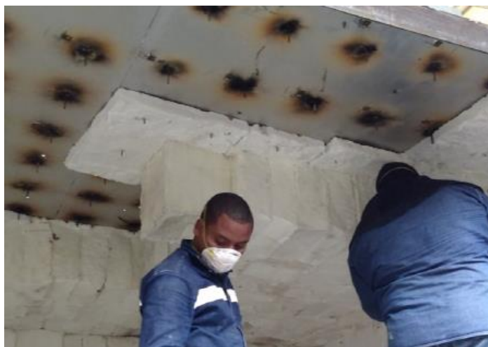
Figura 11. Instalación de fibra Cerámica En Superficie De Techo De Horno
