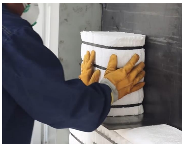
Figura 7. Fijación módulo de fibra cerámica
