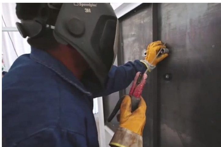
Figura 12. Perforación superficie puntos calientes, pulido y soldado de tubos hembras
