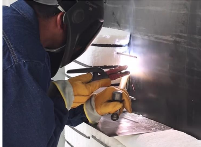
Figura 8. Fijación Ancla Tipo H
