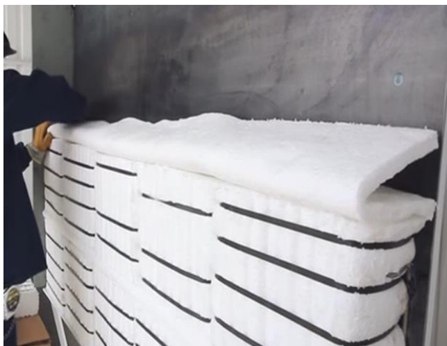
Figura 10. Instalación Junta de Expansión sobre línea módulos de fibra cerámica.
