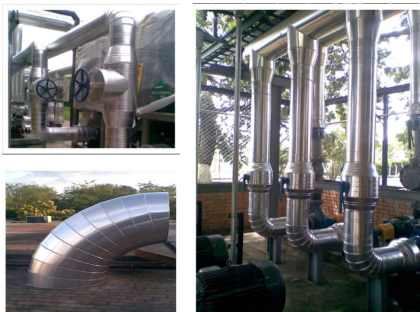
Figura 2. Servicio en Aislamiento térmico en frío, caliente, Acústico Romar Ingeniería S.A.S.
