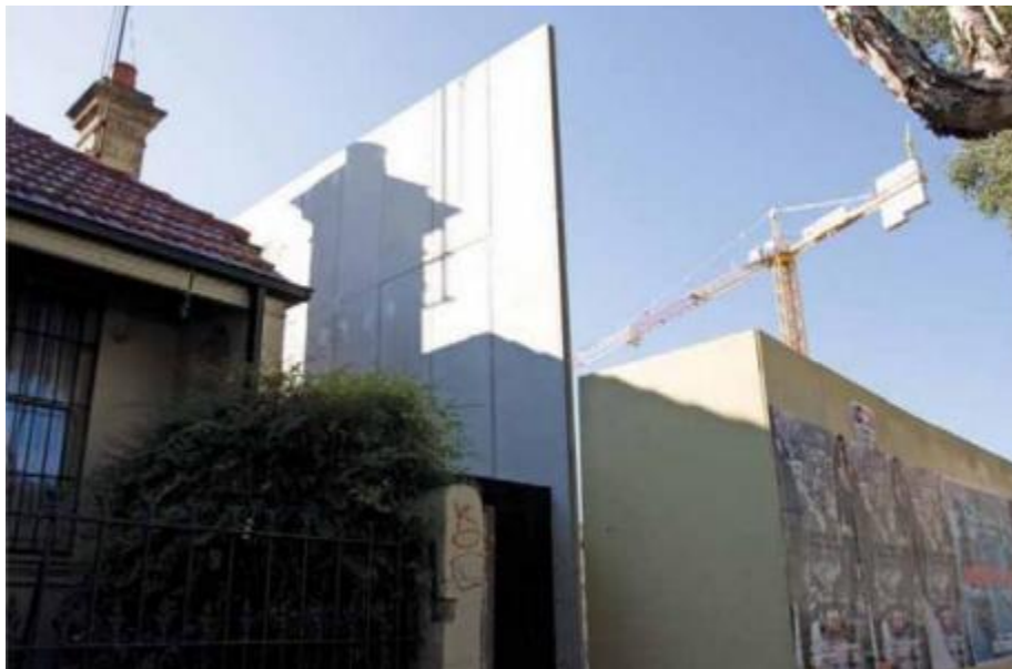
Figura 4. Barrera acústica rígida en Chile. Tomado de: SMA.
