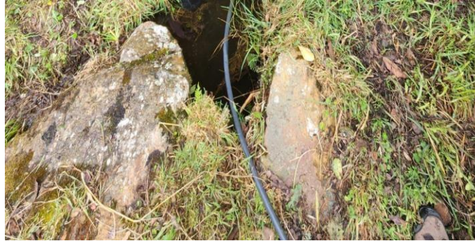
Ilustración 112 Redes expuestas; Fuente: (Carreño,2023)
