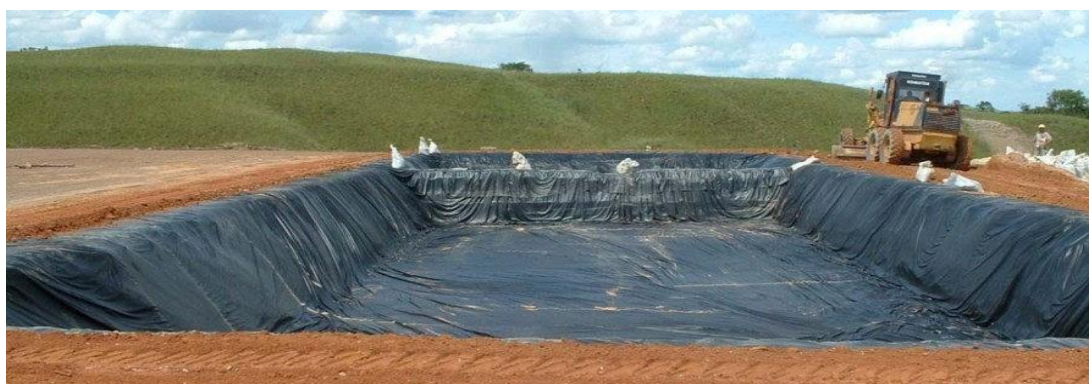
Ilustración 15. prototipo de impermeabilización de reservorio 2 (pág. web)
