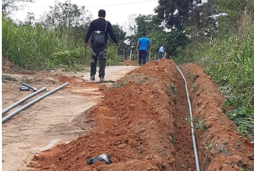
Ilustración 114 Instalación de tubería; Fuente: (EMAPASR-EP,2020)
