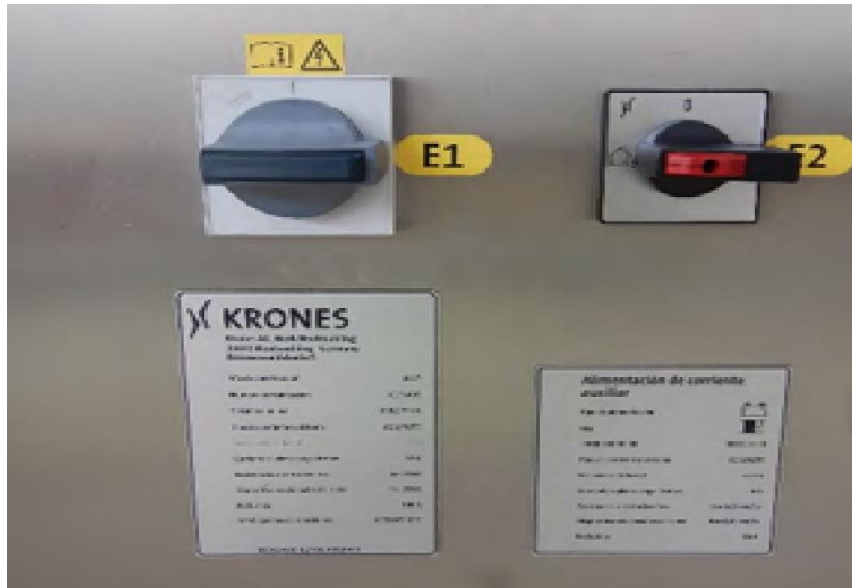
Figura 6. Alimentación eléctrica de potencia y control a 440 Voltios AC de una llenadora de botellas en Central Cervecera.
