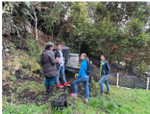
Fotografía 8 Tanque de Repartición Luz Gil; Fuente: Propia
