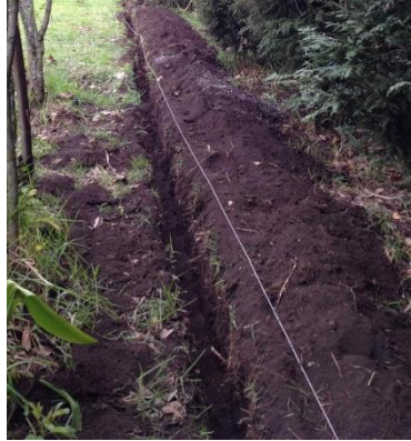
Ilustración 109 Construcción de la zanja; Fuente: (EMAPASR-EP,2020)
