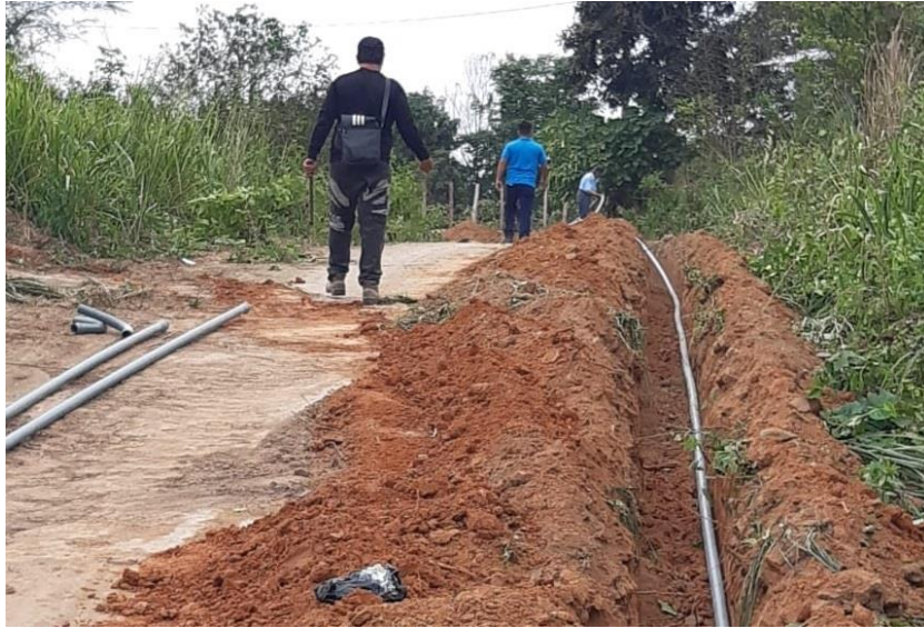
Ilustración 110 Instalación de tubería; Fuente: (EMAPASR-EP,2020)
