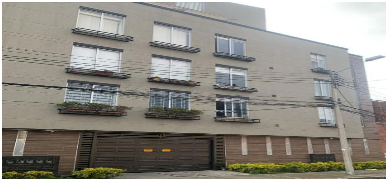
Ilustración 6 Edificación multifamiliar nueva. Fuente: Fotografía de elaboración propia.
