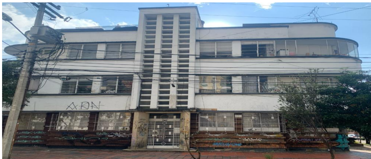
Ilustración 4 Edificación multifamiliar antigua. Fuente: Fotografía de elaboración propia.
