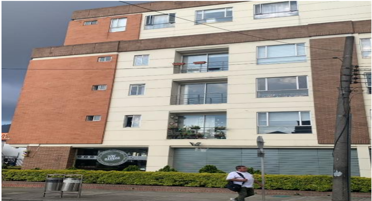
Ilustración 7 Edificación multifamiliar nueva. Fuente: Fotografía de elaboración propia.
