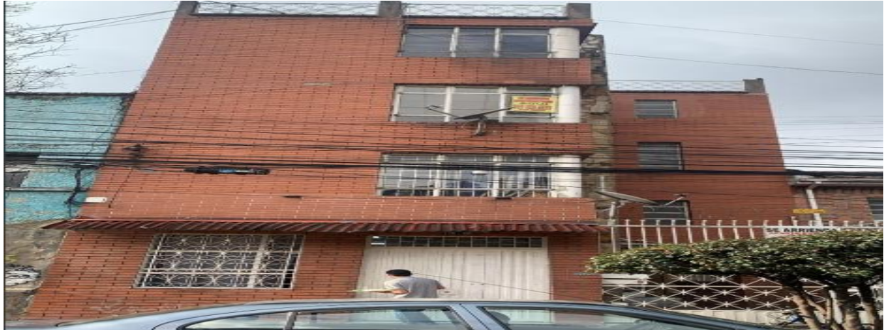
Ilustración 5 Edificación multifamiliar antigua. Fuente: Fotografía de elaboración propia.
