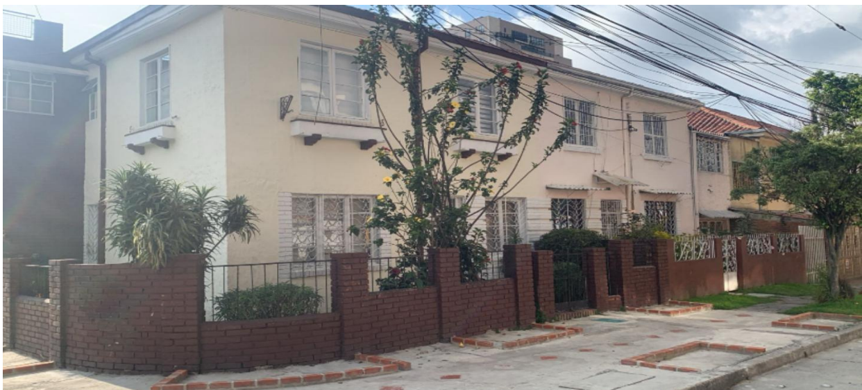
Ilustración 8 Casa antigua. Fuente: Fotografía de elaboración propia.
