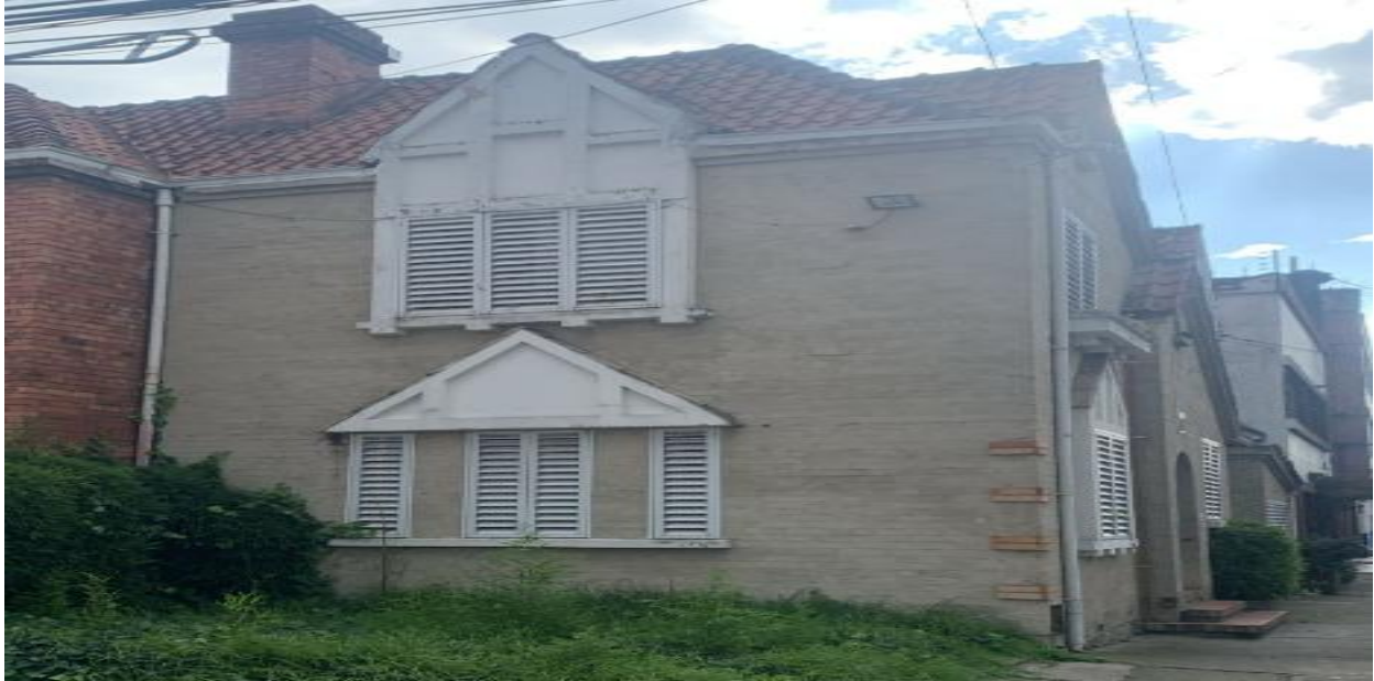
Ilustración 9 Casa antigua. Fuente: Fotografía de elaboración propia.
