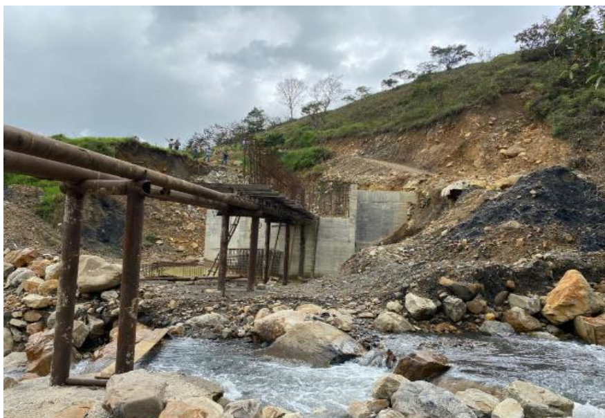
Ilustración 6. Instalación de obra falsa, ocupación de cauce. (Fuente propia, 2021)
