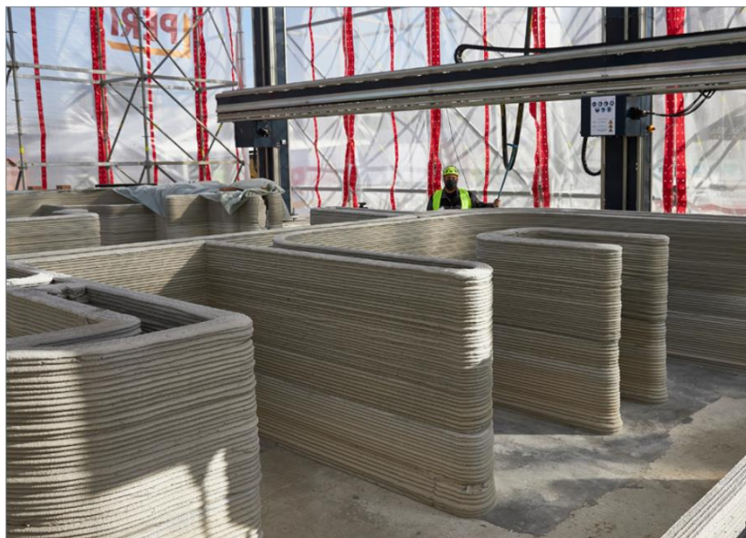
Figura 1. Construcción de una casa utilizando la impresión 3D en Alemania.
