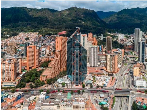
Ilustración 9 Edificio atrio de Bogota
