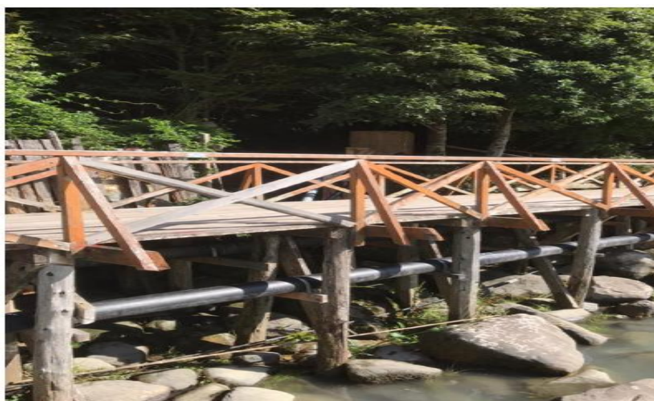
Figura 13. Tubería de vacío instalada debajo de pasarelas de madera.
