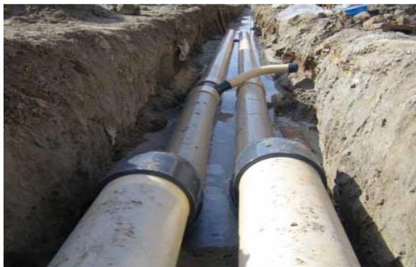
Instalación de red de alcantarillado por vacío.
