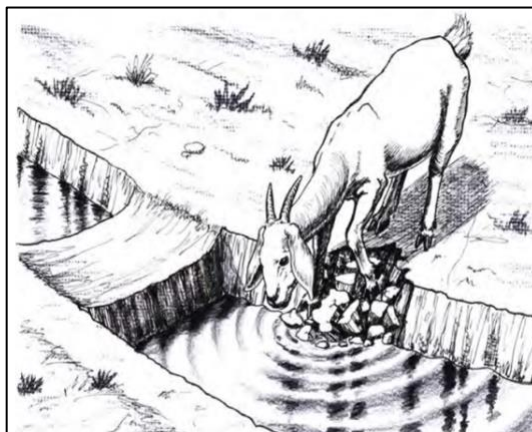
Ilustración 4 Daño en la zanja por animales. Fuente. Cartilla de capacitación JALDA
