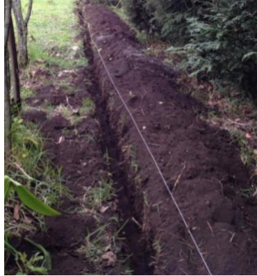
Ilustración 3 Construcción de la zanja; Fuente: (EMAPASR-EP,2020)
