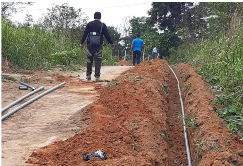
Ilustración 5 Instalación de tubería; Fuente: (EMAPASR-EP,2020)
