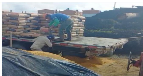
Ilustración 32. Fotografía de colaboradores cargando un bulto de cemento
