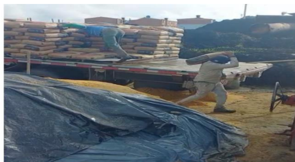
Ilustración 31. Fotografía de colaboradores trasladando un bulto de cemento
